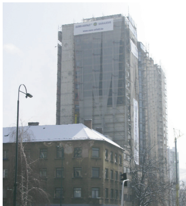
Hotel „Bristol“ (u izgradnji)
